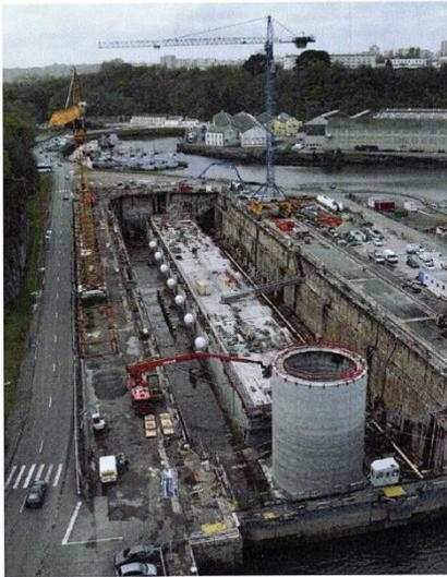
*Construction du ponton et du musoir en forme de radoub, avant mise en eau*
